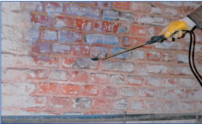
Nach gründlicher Untergrundvorbereitung erfolgt die Grundierung mit INTRASIT® Aquarol weiß
