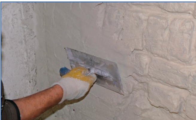
Auftragen des Klimaleichtputzes INTRASIT® RZ 2
