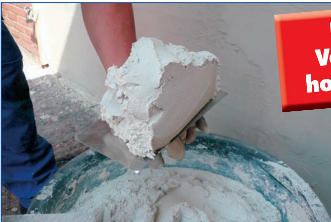
Auftragen des Klimaleichtputzes INTRASIT® RZ 2
