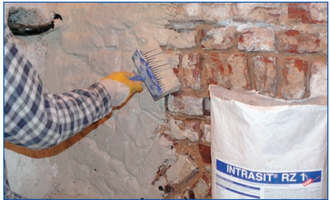
Flächenabdichtung mit INTRASIT® RZ 1 als Schlämmauftrag oder als Dichtungsmörtel mit anschließendem Haftspritzbewurf
