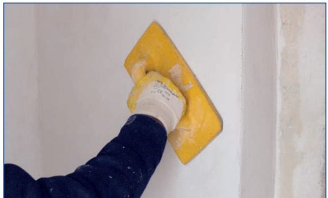
Abreiben der Oberfläche von INTRASIT® RZ 2
