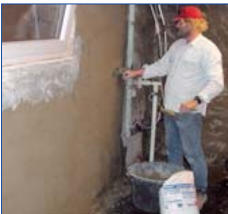
7 Das anschließende Verputzen der Wandflächen mit INTRASIT® Sanierputz WTA grau/weiß oder -SanUno erfolgt nach den Regeln der Putztechnik zweilagig bis 20 mm.
