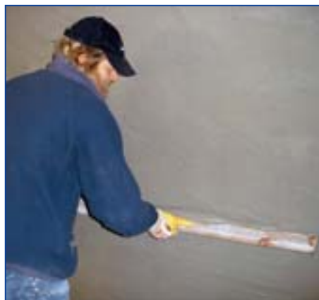
8 Bei höheren Putzstärken bzw. bei stark zerklüfteten Mauerwerken kann alternativ INTRASIT® SanUno WTA einlagig bis zu einer Gesamtputzdicke von 30 mm aufgetragen werden.
