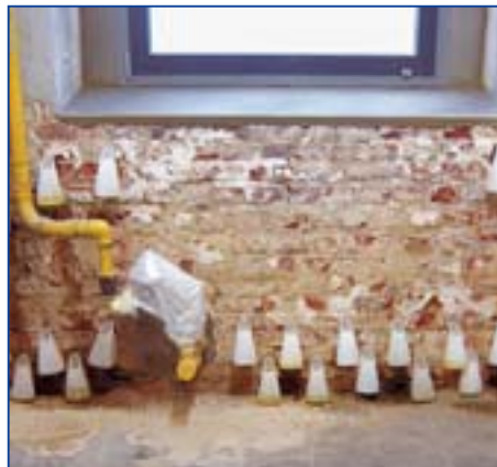
5 Bohrlöcher vornässen. INTRASIT® Verkieselung oder INTRASIT® MEK/-BLK über die Bohrlöcher in den Wandquerschnitt bringen. Nach Beendigung der Injektgearbeiten die Bohrlöcher mit INTRASIT® Bohrlochsuspension verfüllen.
