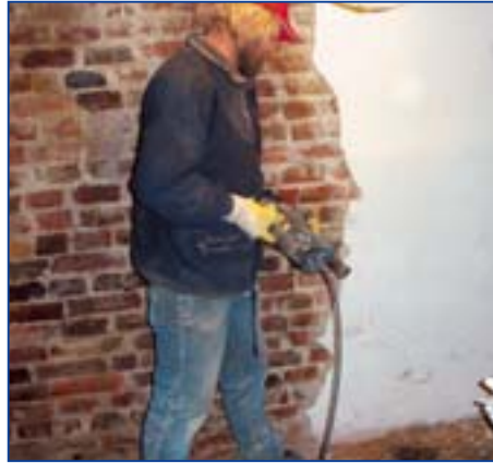
2 Salzbelasteten Putz vollständig entfernen. Losen Fugenmörtel auskratzen.
