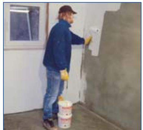
9 Die Schlussbeschichtung der Sanierputzoberfläche kann ausschließlich mit dampf-offenen Systemen erfolgen. Als Anstrich VESTEROL® Silikatfarbe verwenden.
