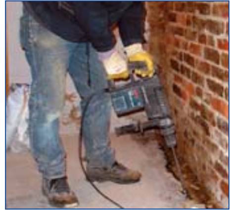
3 Zum Wandanschluß hin vorhandenen Estrich bis zu einer Breite von 30 cm entfernen.
