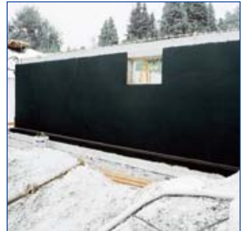
6 Fertig und sicher abgedichtet mit IMBERAL® 2K Winter .
