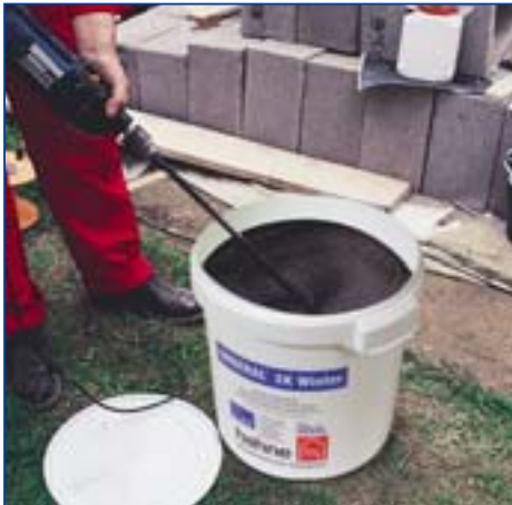
4 IMBERAL® 2K Winter durch langsam laufendes Rührwerkzeug mit Rührpaddel anrühren.
