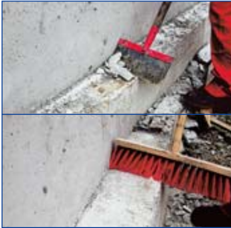
1 Untergrund gründlich reinigen und Sinterschichten entfernen.
