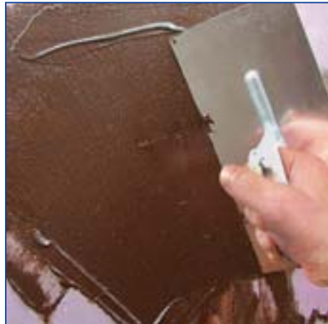
5 Offene, profilierte Oberflächen sowie Poren in Betonflächen mit IMBERAL® 2K Winter als Kratzspachtelung schließen.
