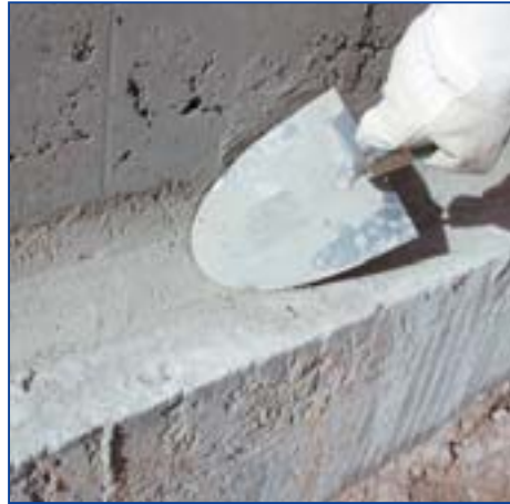
2 Hohlkehlen mit INTRASIT® FSM Winter im Radius von ca. 5 cm ausbilden. Ausbrüche im Mauerwerk sowie zurückspringende Fugen (> 5 mm) ebenfalls mit INTRASIT® FSM Winter schließen.
